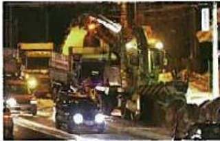
●一車線積込作業(縦列)
